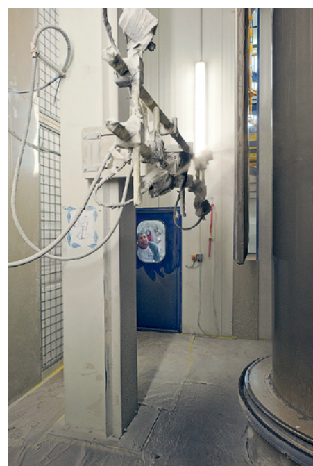
Der Spritzroboter bewegt sich in vertikaler Richtung entlang einer Säule. Die Spritzpistolen geben nur in jenen Bereichen Farbe ab, die beim Einfahren mittels Scanner detektiert wurden.
